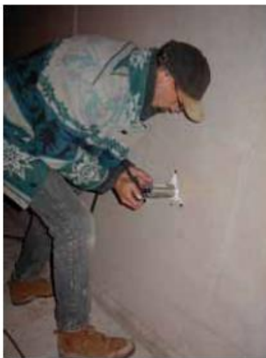
Medición de espesor en un túnel colado en el lugar
